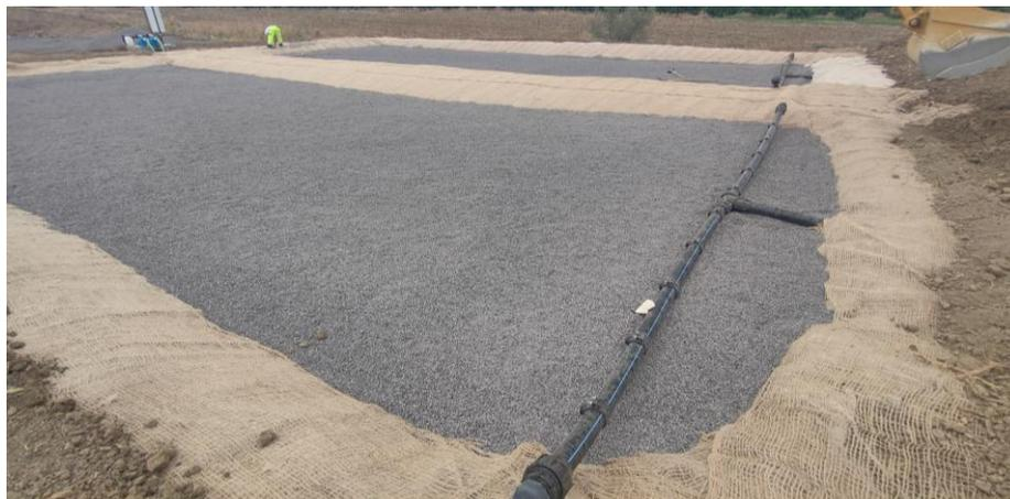
Figura 2.9: Unità di fitodepurazione H-SSF dopo la posa in opera dei medium di riempimento.
