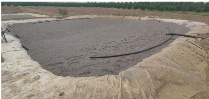
**Figura 2.6:** Unità di fitodepurazione V-SSF: fase di posa in opera degli strati di inerti per la realizzazione del substrato filtrante
