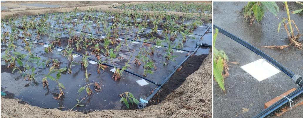
**Figura 2.7: Unità di fitodepurazione V-SSF: sistema di distribuzione delle acque reflue**
