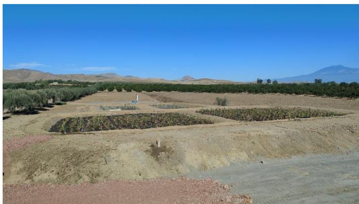
Figura 2.2: Sistema di fitodepurazione ibrido a flusso sub-superficiale per il trattamento delle acque di riciclo dell'invaso di allevamento ittico dell'azienda agricola Arena Giuseppe.
