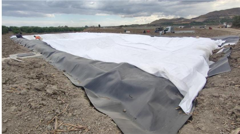
**Figura 2.5:** Sistema di impermeabilizzazione delle vasche di fitodepurazione costituito da un telo in HDPE posato in opera tra due strati di tessuto non tessuto.
