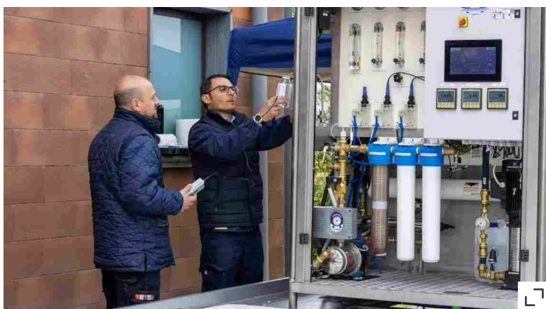
Tecnici dell'Università di Catania mostrano il funzionamento dell'impianto di desalinizzazione
