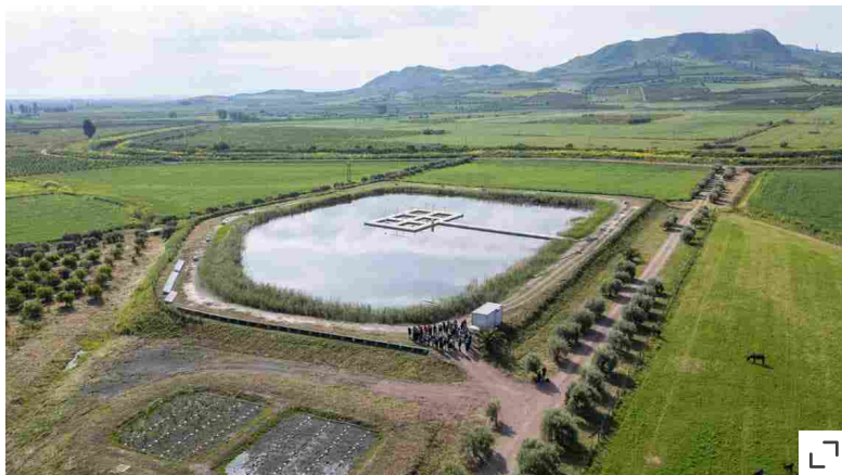
L'impianto di fitodepurazione nell'azienda agricola "Fratelli Arena". Accanto al laghetto le piante di papiro
