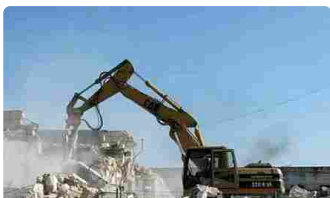
A Triscina verranno demoliti 85 immobili abusivi, gara aggiudicata definitivamente
